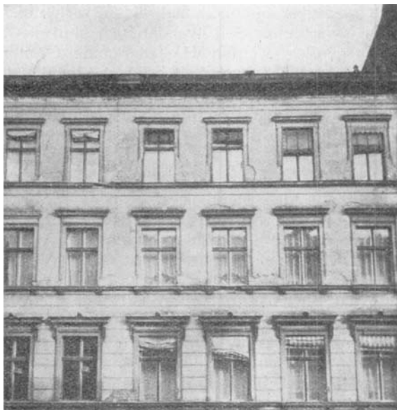
Abb. 1. Zerstörungen von Putz durch herabsickerndes Wasser: Die Simse haben das Austreten des Wassers aus dem Putz durch Herabsacken nach unten verhindert und das Wasser stets zwischen den Fenstern gehalten. Hier hat das gefrierende Wasser den Putz im Laufe der Zeit zerstört, besonders in den oberen Stockwerken.
