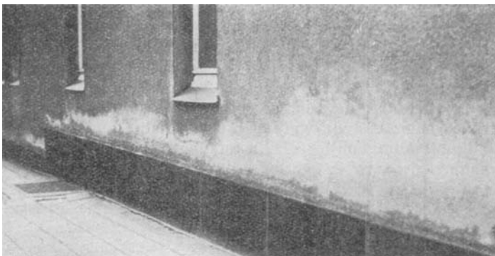
Abb. 2. Sulfatzerstörung von Putz: Das aus der ganzen Wand des 4stöckigen Hauses ausgewaschene Sulfat hat sich in dem Sockel, da das Wasser nicht ablaufen konnte, sondern verdunstete, konzentriert. Der Putz hat einen Sulfatgehalt von 3,72% \text{SO}_3 , welcher zur Zerstörung führte.
